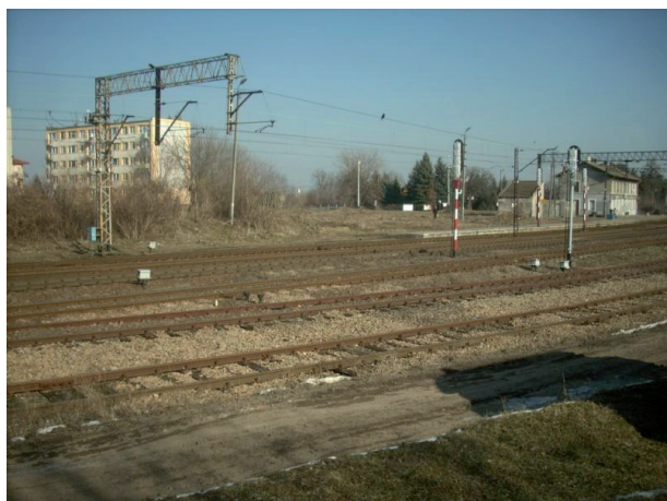
Rys. 5.2.13. Stanowisko pomiarowe monitoringu hałasu kolejowego w Żurawicy przy ul. Wapowskiego [28]
