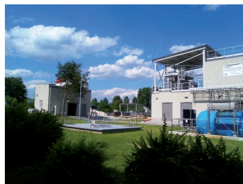
Rys. 4.1.1. Oczyszczalnia ścieków w Głogowie Małopolskim, zmodernizowana w 2015 r. [28]
