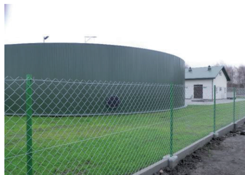
Rys. 4.3.2. Oczyszczalnia ścieków w Wierzbiej, zmodernizowana w 2014 r.[28]
