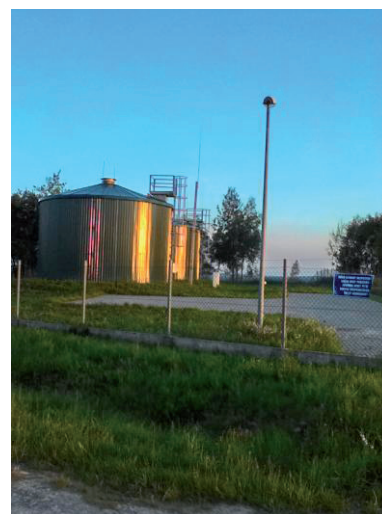
Rys. 4.1.8. Strefa ochrony bezpośredniej ujęcia wody podziemnej, zbiorniki wody pitnej w Tarnawce [28]
