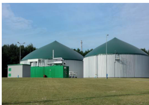
Rys. 7.2.5. Biogazownia Rolnicza w Starym Mieście k. Leżajska [26]
